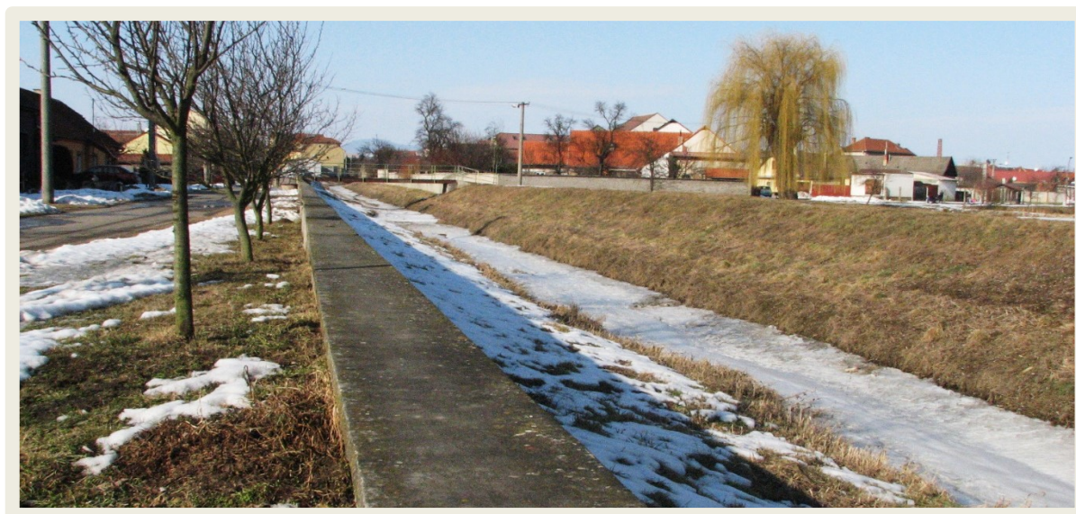
Obr. 7. Řeka Dlouhá [Zdroj: Vlastní zpracování]
