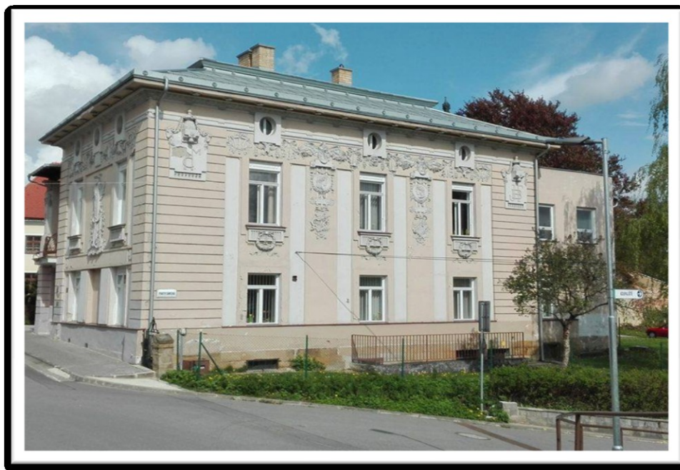
Obrázek 15 Aktuální stav boční fasády Bratmannovy vily ve Valašských Kloboukách k r. 2017
