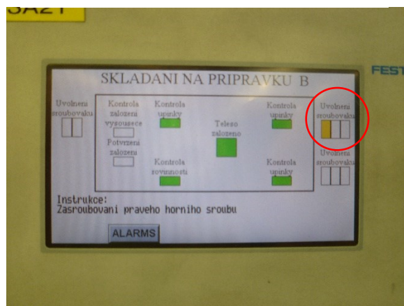
Obrázek 16: Potvrzení šroubování (zdroj: vlastní fotografie)
