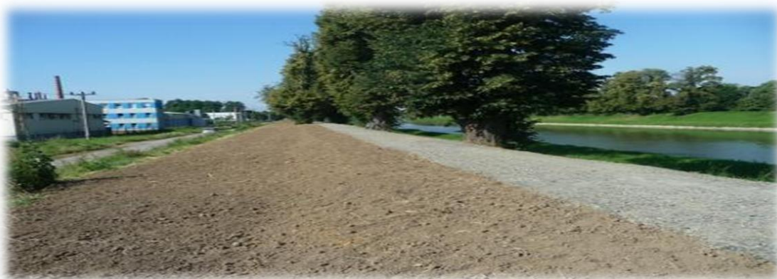
Obrázek 19 Ochranná hráze v blízkosti průmyslové zóny v Mařaticích
