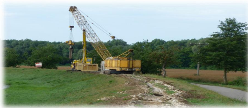
Obrázek 21 Sanace průsaku ochranné hráze v Nedakonících
