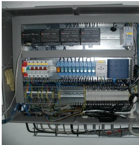
Obr.11 Programovatelný automat v rozvaděči [11]
