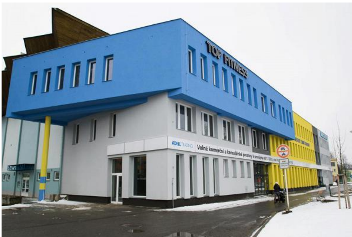
Obr. 11. Budova zimního stadionu 52
