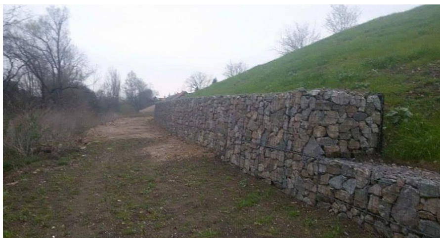
Obr. 8. Výstavba gabionové stěny v horní části obce [Zdroj: vlastní]
