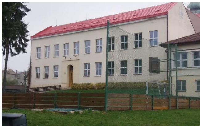
Obr. 3 Budova na Podvalí
