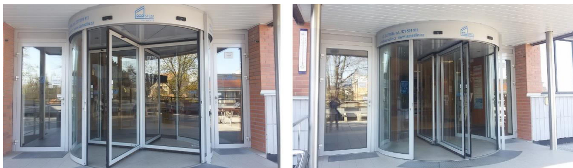
Obr. 15. Běžný režim turniketových dveří (vlevo) a dveře v režimu PANIK (vpravo) [36]
