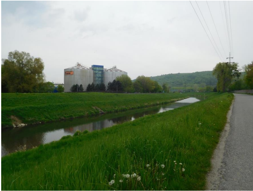
Obrázek 10: Čistírna odpadních vod [Zdroj: vlastní]
