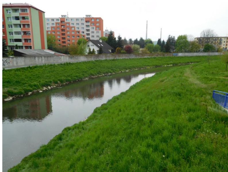
Obrázek 9: Protipovodňové stěny [Zdroj: vlastní]
