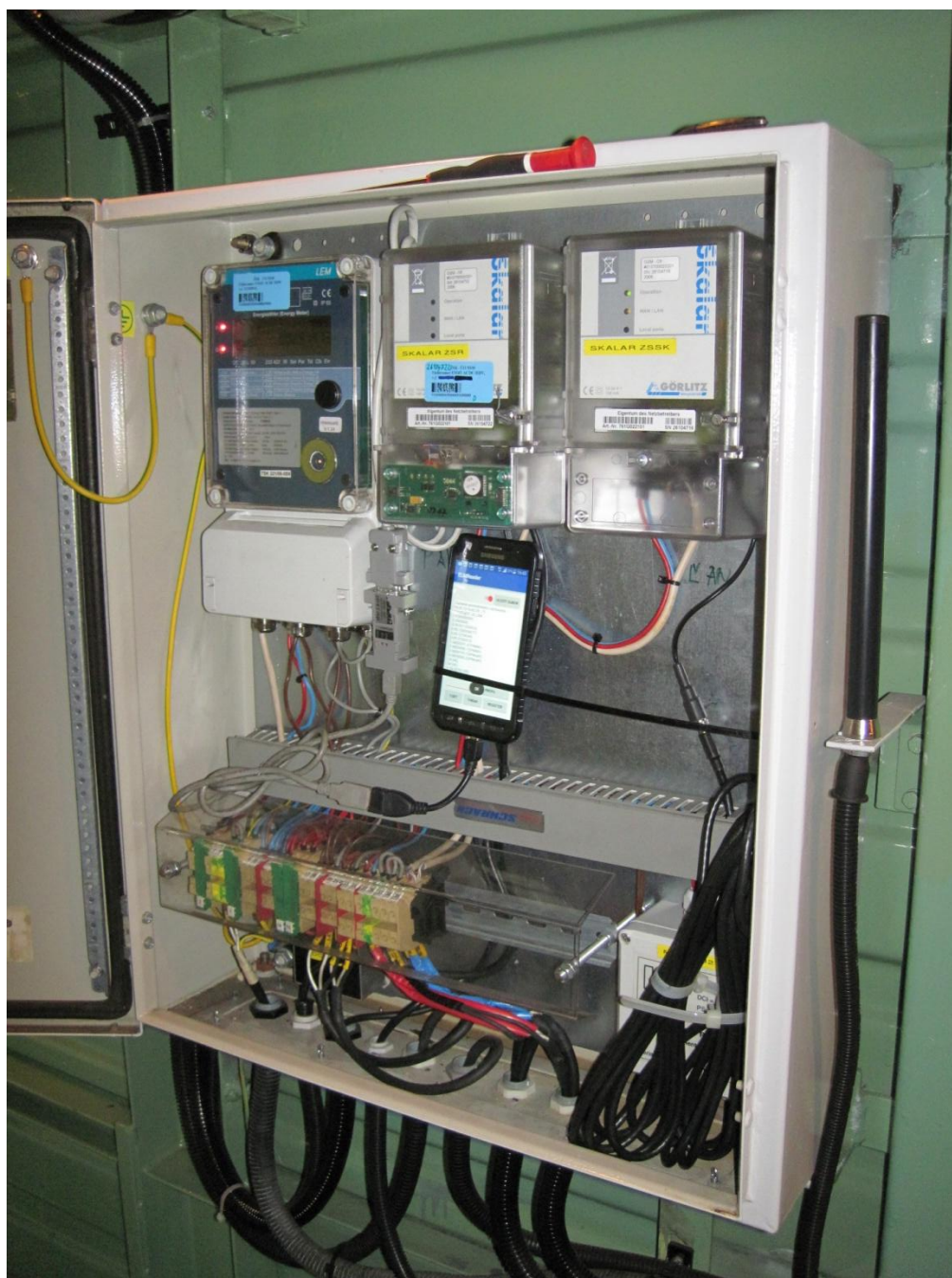
Obrázok 34 Skriňa merania Škoda s inštalovaným telefónom Samsung
