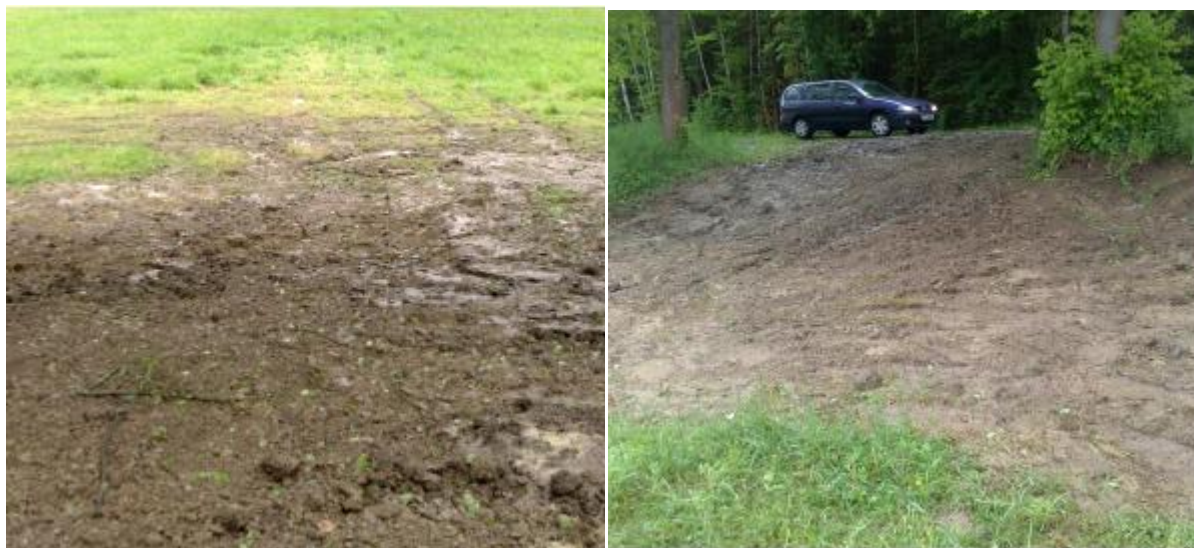
Obrázek 13 Konečný závoz interní zeminou, Zdroj: [34]
