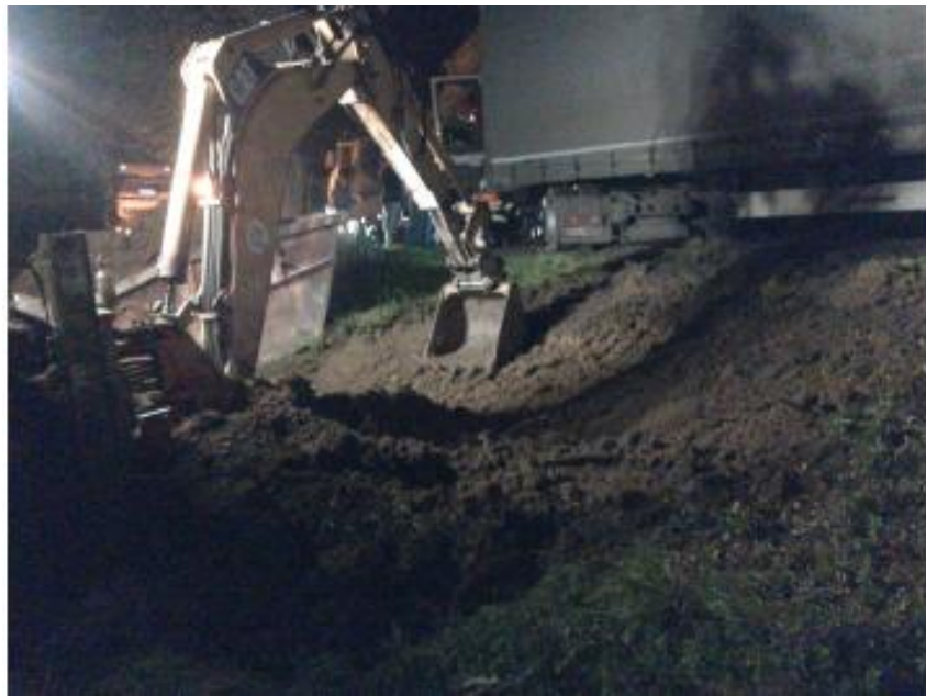
Obrázek 11 Odtěžba kontaminované zeminy, Zdroj:[34]
