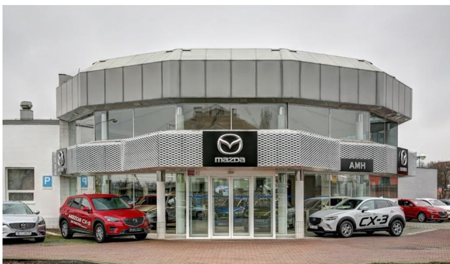
Obr. 3. Sídlo společnosti AMH a. s. (interní zdroje společnosti)
