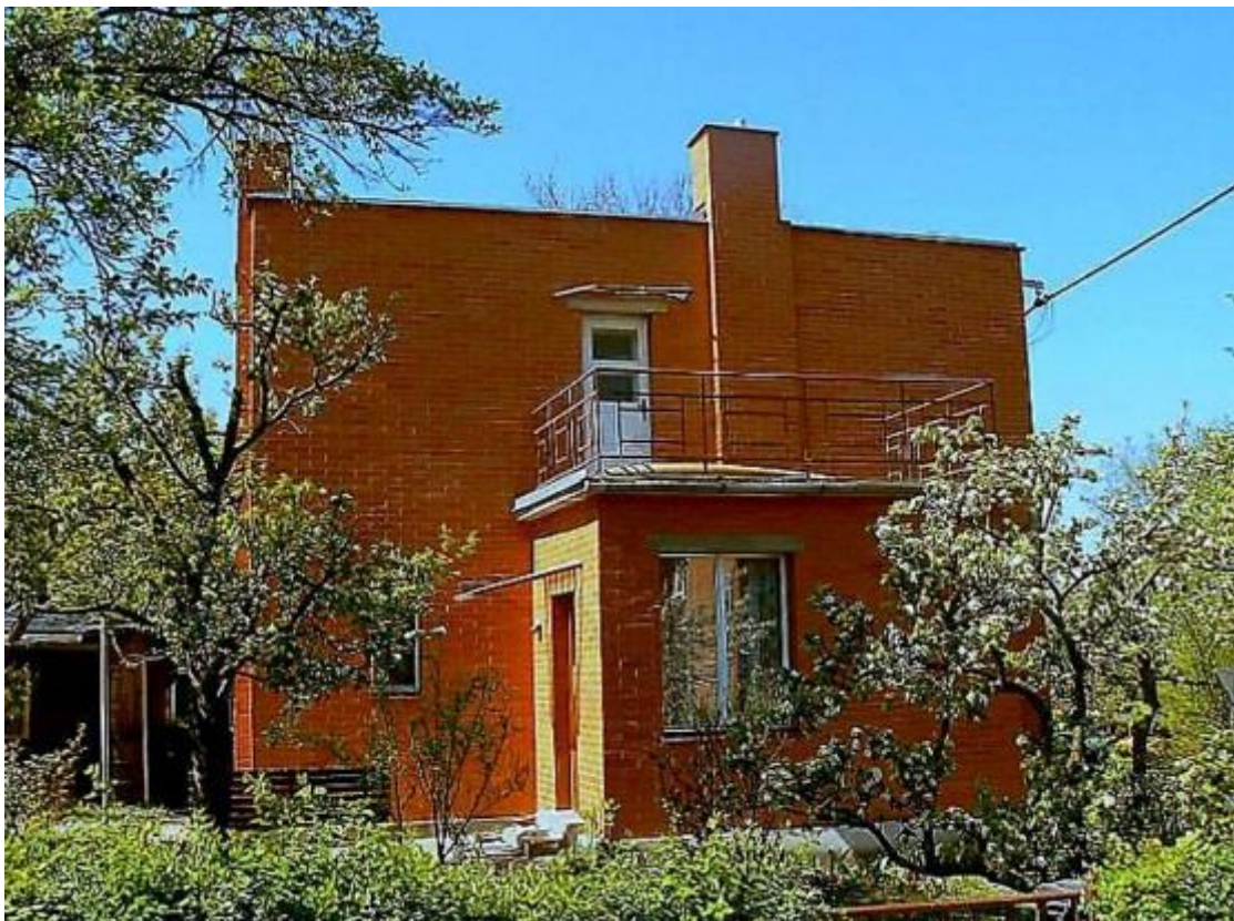
Obrázek 2: Baťovský domek v původním stavu na Bahňáku v Otrokovicích
