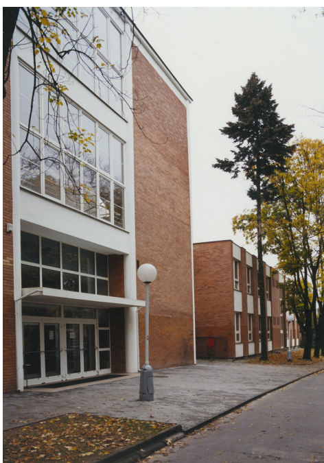
Obr. 3 Budova FMK v r. 2001
