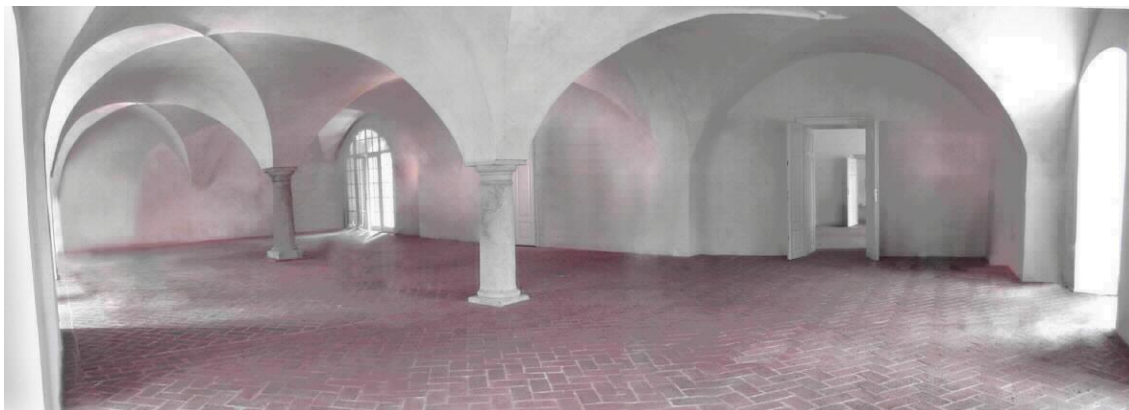
renesanční sál po rekonstrukci
