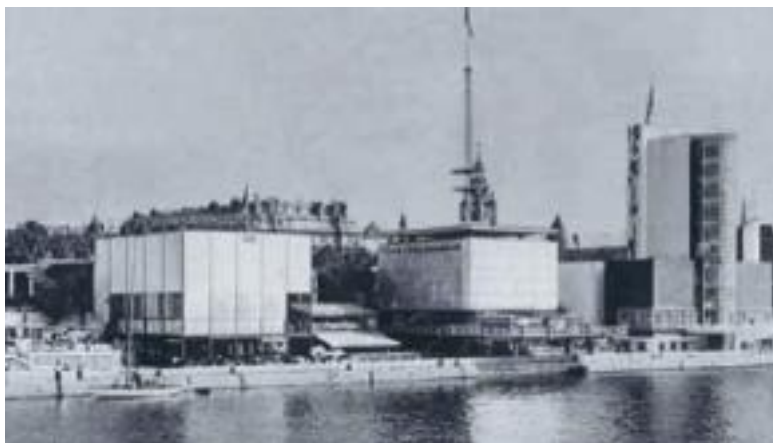
obr.5. Celkový pohled na výstavní pavilon
