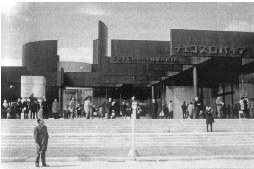
obr. 10 Vstupní část československého pavilonu
