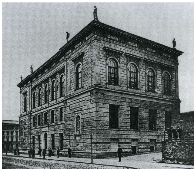
obr. 1) Pohled na exteriér muzea v době jeho postavení
