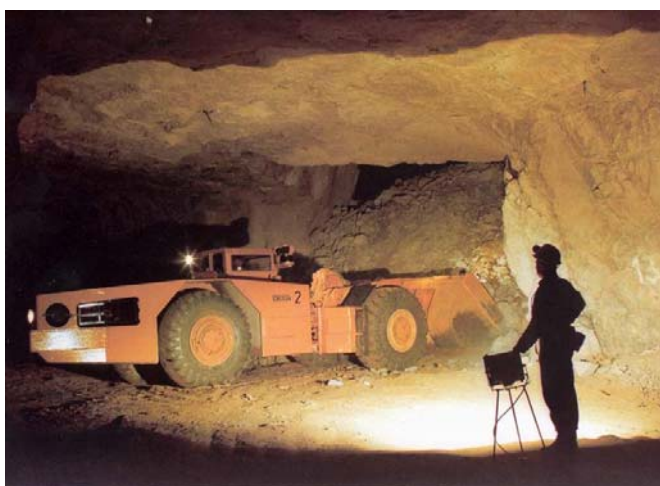
Zakladanie vytŕažených priestorov
