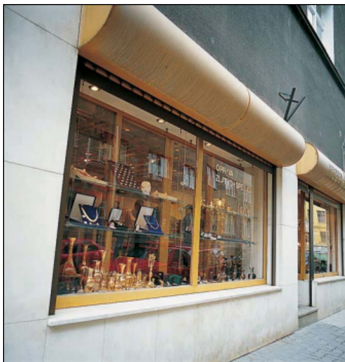
Obr. 25. Lexan Margard MR5E – tloušťka 6 mm – Bratislava
