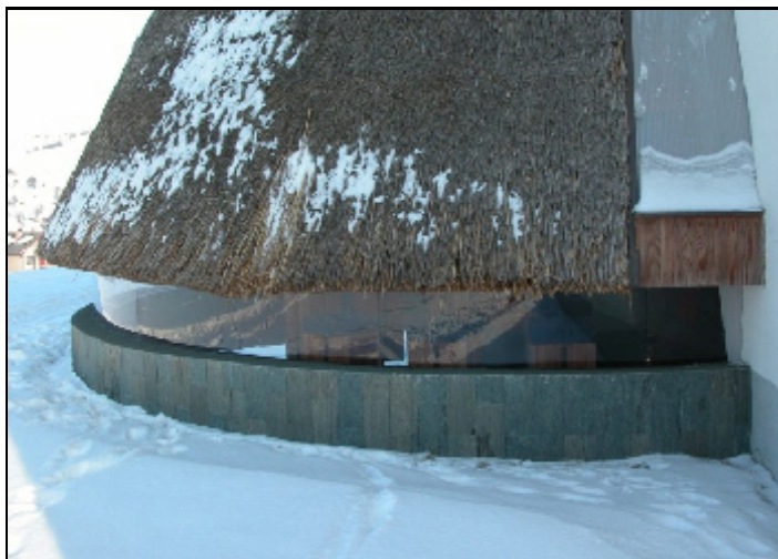
Obr. 24. Lexan Margard – tloušťka 8 mm – Liptovské Revúce
