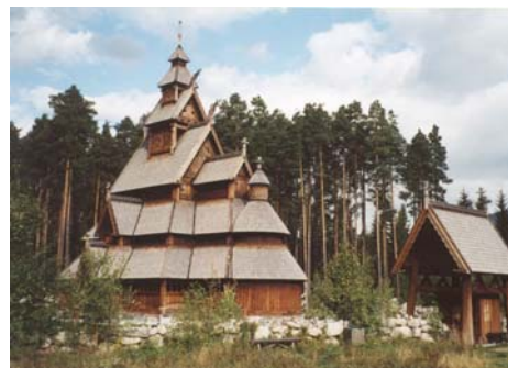
Obr. 1. Stavkirke v Golu
