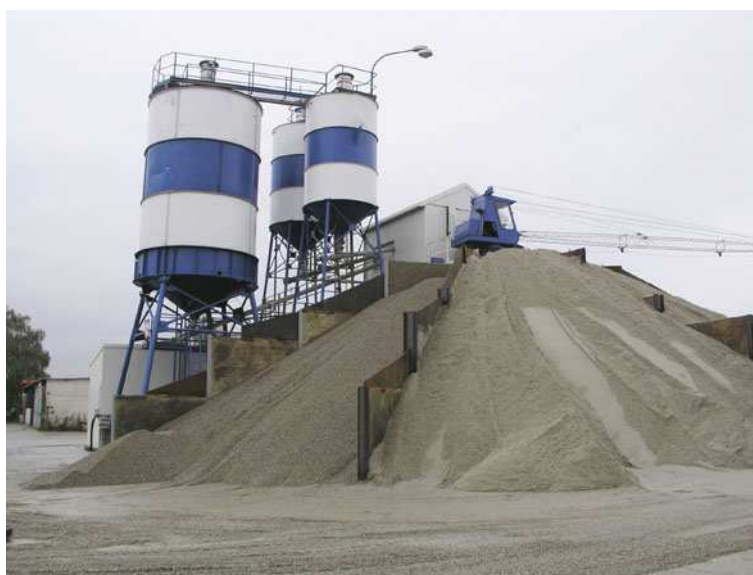
Obr. 14. Betonárna Uherský Brod.
