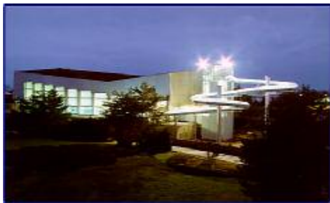
Obrázek 3 Krytý bazén Olomouc
