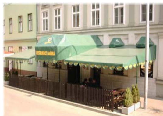
Obr. 11: Restaurace a zahrádka
