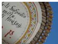
Obr.č.13 Detail šindele - poslední řada z kozubu na staré jídelně. Z obrázku je patrný přesah horních šindelů i způsob jejich vyřezávání.
