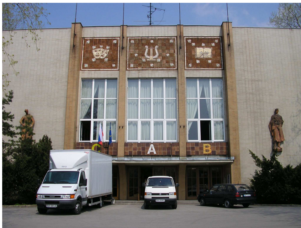
Obr. 20 Vstupná hala – pohľad zpredu
