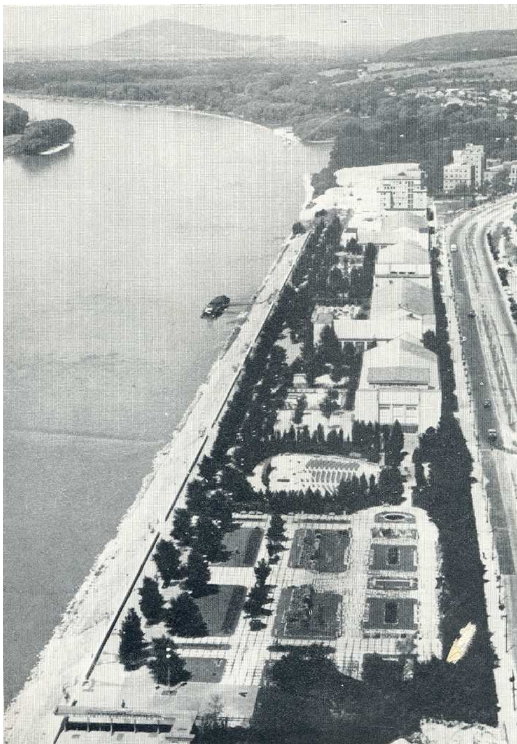
Obr. 11 Areál PKO pred postavením montovaných pavilónov
