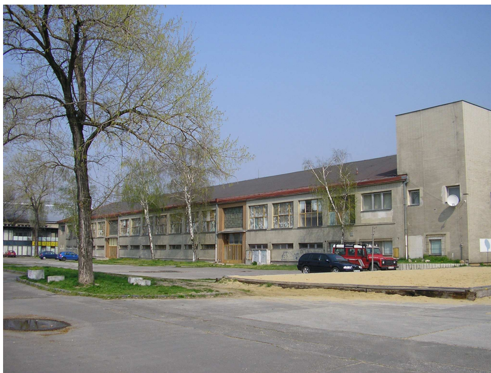
Obr. 19 Šporová hala – pohľad z boku
