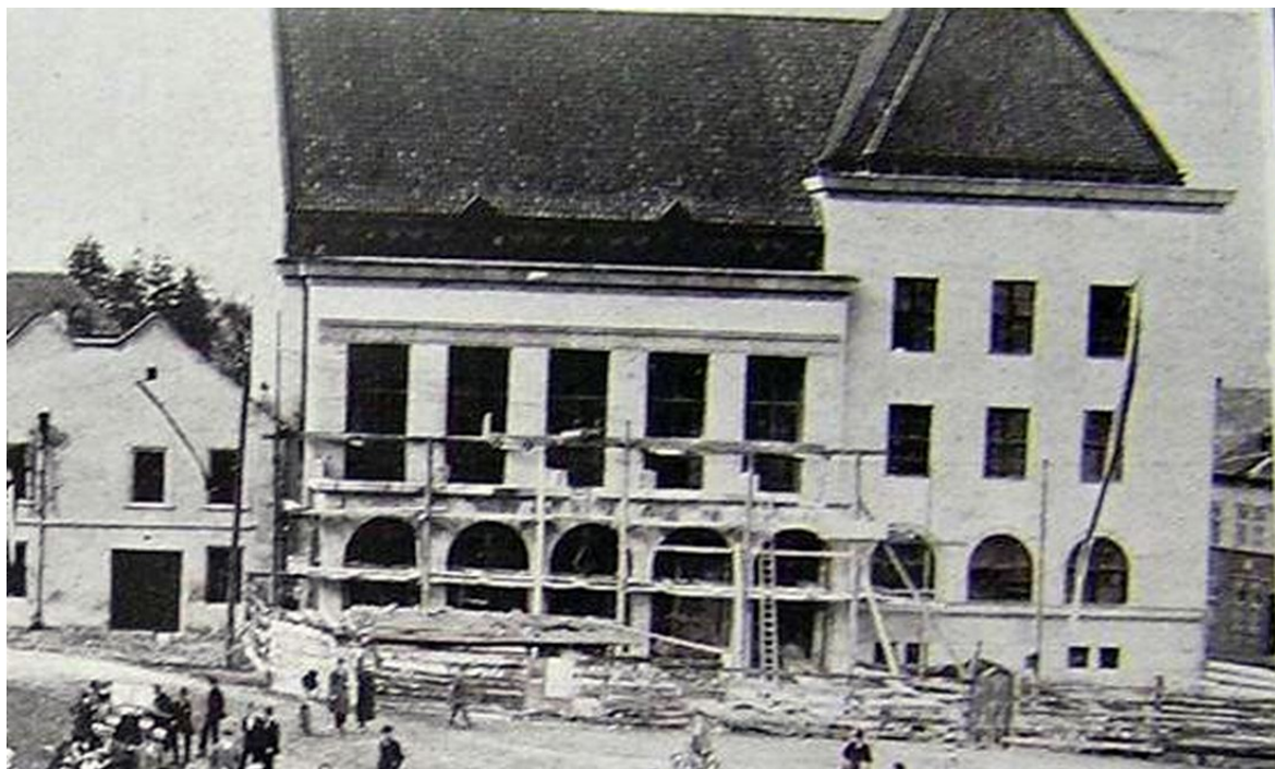
Obr. 4. Hrubá stavba nové zlínské radnice – stav k říjnu 1923.
