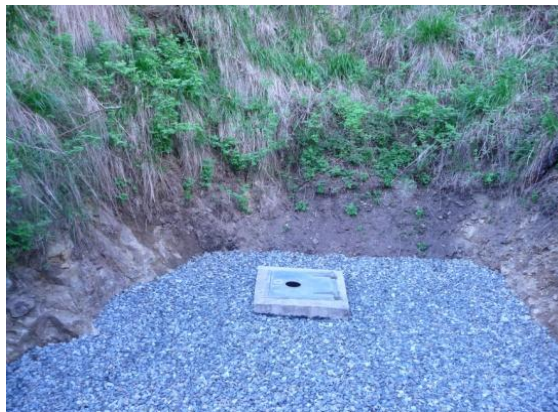
Obrázek 12. Druhý vchod do štoly Pekelská
