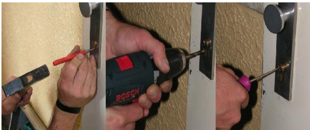
Obrázek 22 Odvrtání stavítek
