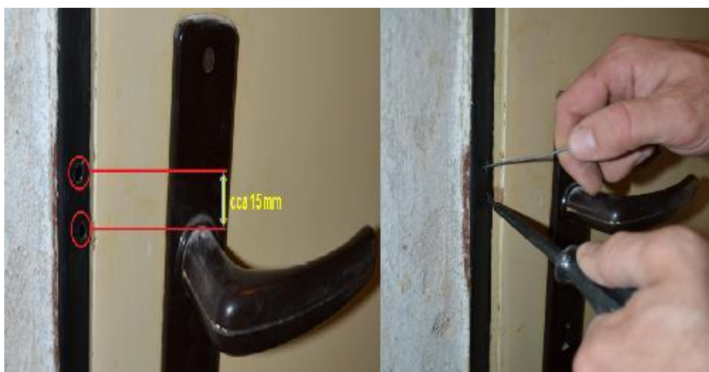
Obrázek 20 Vrtání do zárubní [Zdroj: autor]
