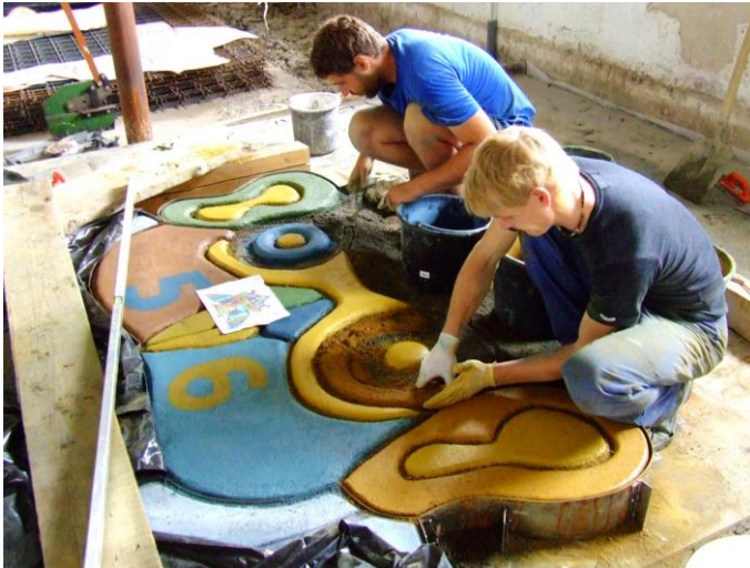
Ruční výroba skákacího panáka pomocí speciálního betonu 14
