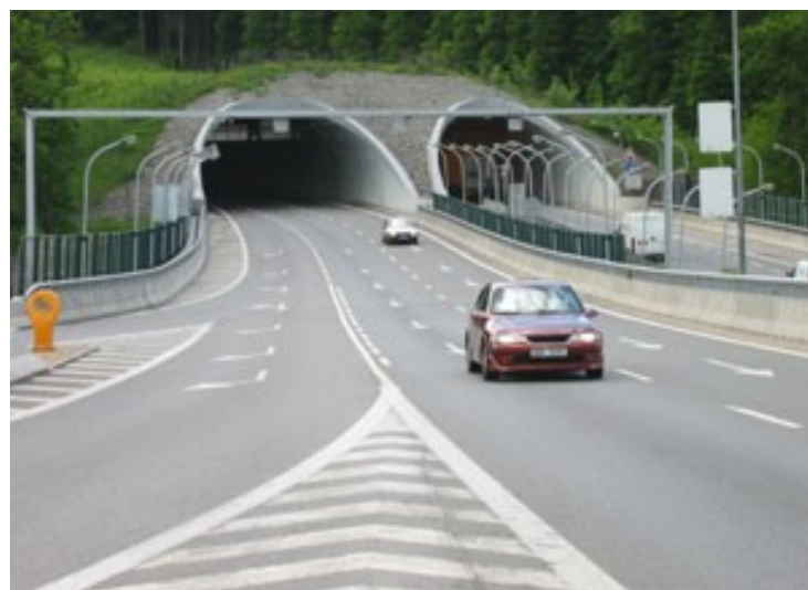
Obrázek 4 Portál Pisáreckého tunelu - směr od Hlinek Zdroj: [12]
