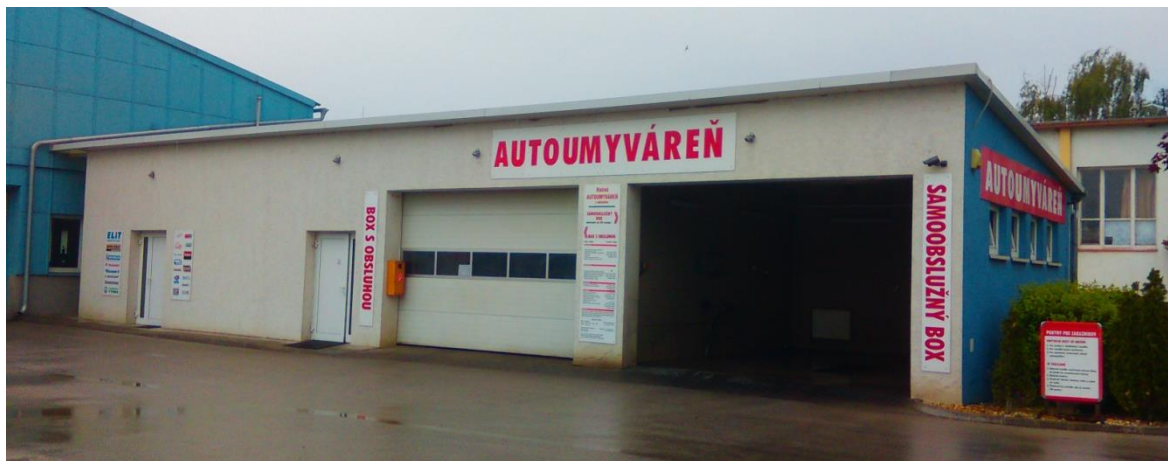
Obrázok 8: Pohľad spredu na sklad, prijímaciu kanceláriu a autoumyváreň [zdroj: autor]
