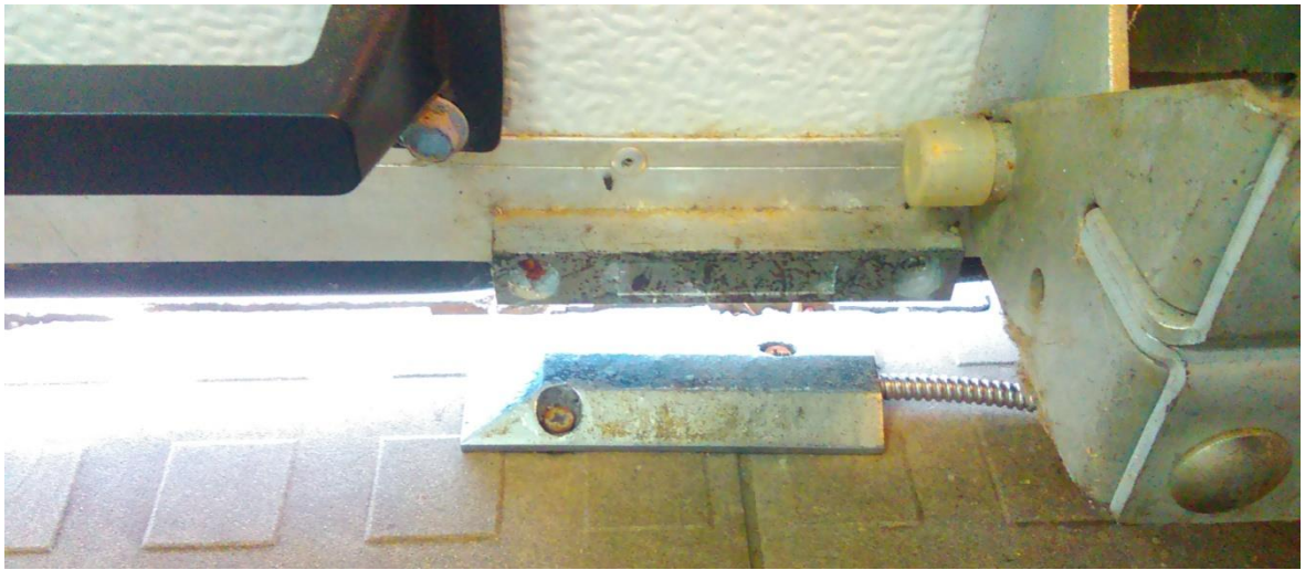
Obrázok 18: Magnetické kontakty na brány [zdroj: autor]
