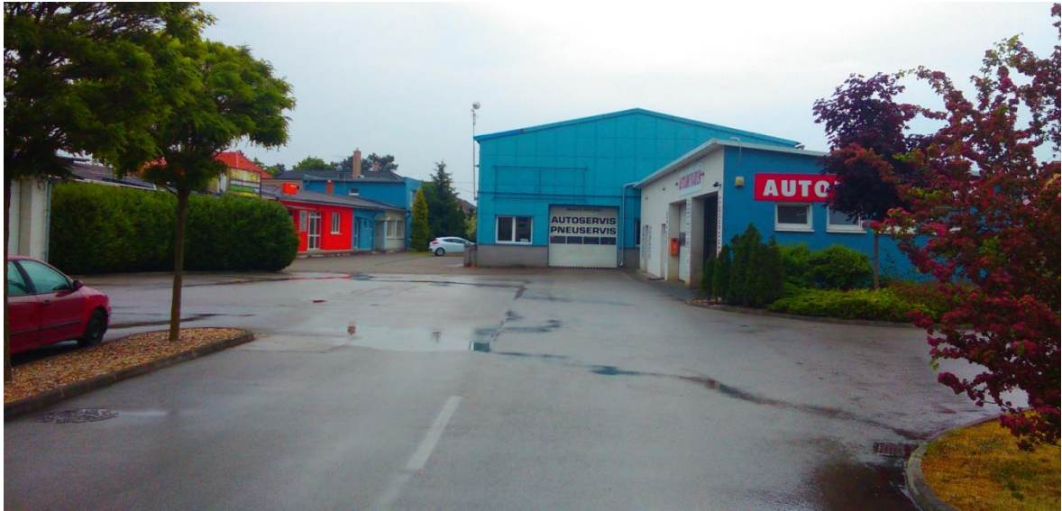
Obrázok 7: Pohľad na objekt od príjazdovej cesty [zdroj: autor]
