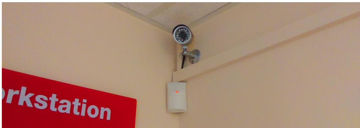
Obrázok 21: PIR detektor a kamera v prijímacej kancelárií [zdroj: autor]
