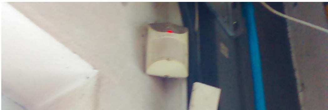
Obrázok 20: PIR detektor – hala [zdroj: autor]
