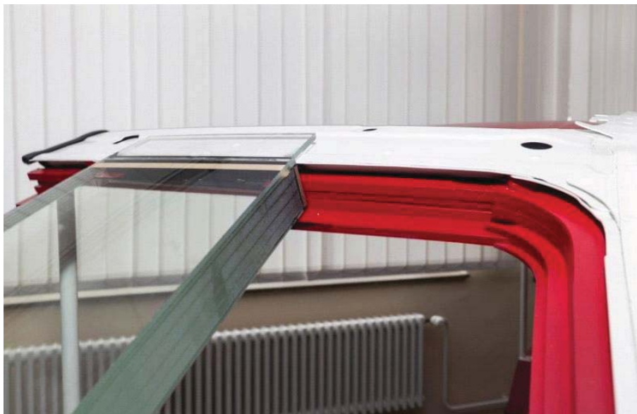
Obr. 15. Montáž balistického skla 36
