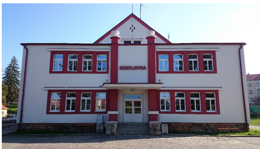
Obrázek 13: Budova Sokolovny – jižní pohled [zdroj: autor]
