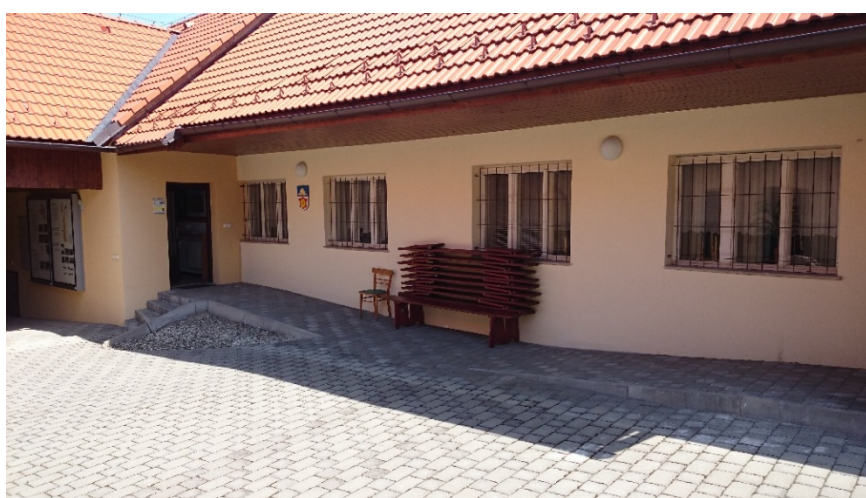
Obrázek 44: Budova městského muzea – západní budova [zdroj: autor]
