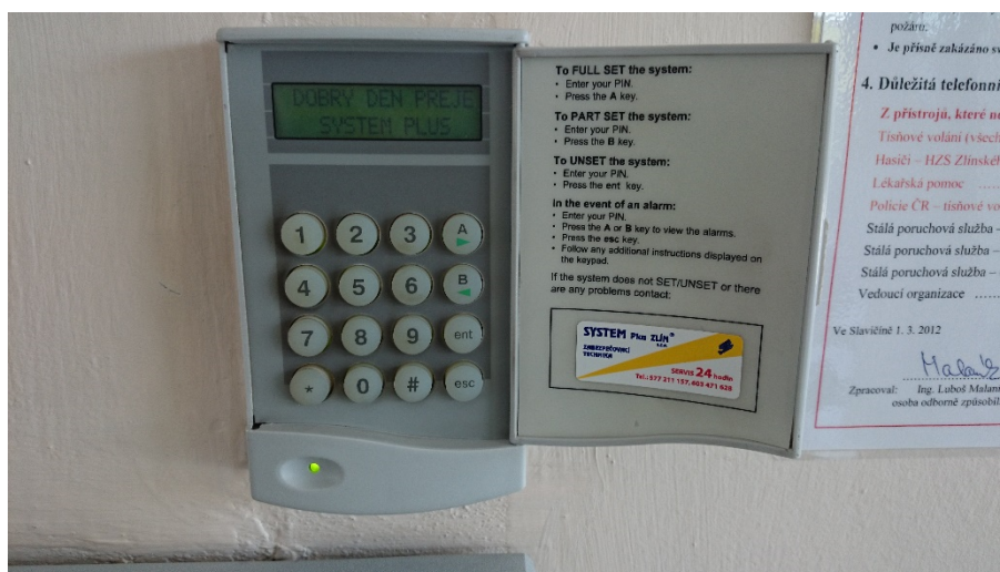
Obrázek 51: Ovládací klávesnice PZTS – městský úřad [zdroj: autor]
