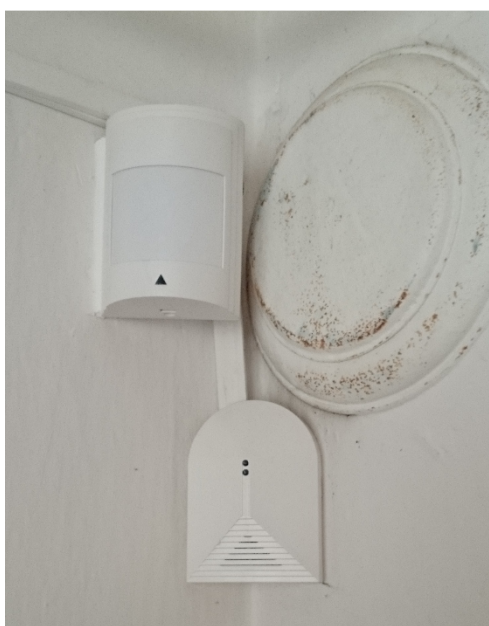
Obrázek 53: Detail PIR a Glassbreak detektoru – městské muzeum [zdroj: autor]
