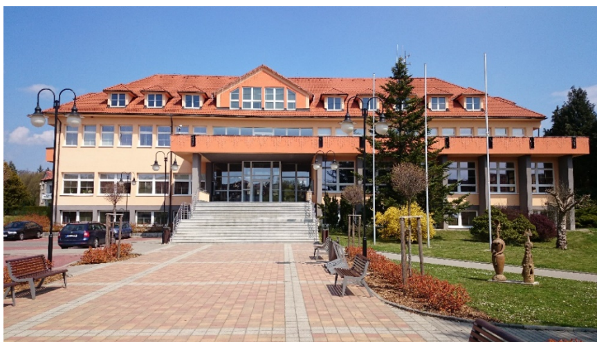
Obrázek 33: Budova Městského úřadu – jižní pohled [zdroj: autor]
