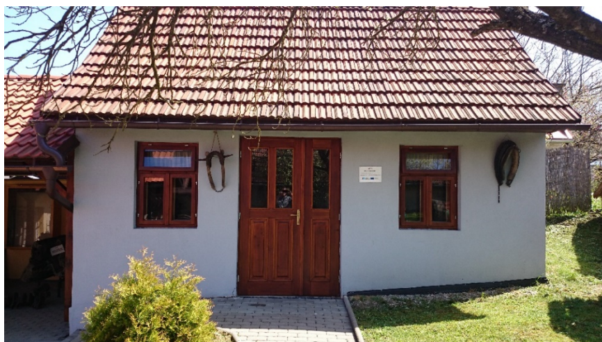
Obrázek 46: Budova městského muzea – přístavba [zdroj: autor]
