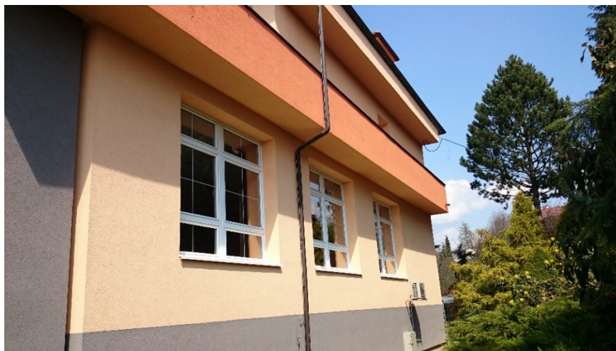
Obrázek 36: Budova Městského úřadu – východní pohled [zdroj: autor]
