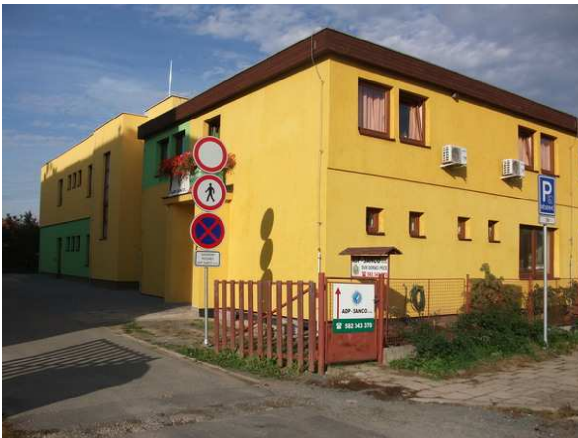
Obr. 1 Objekt společnosti ADP-SANCO s.r.o.[vlastní]
