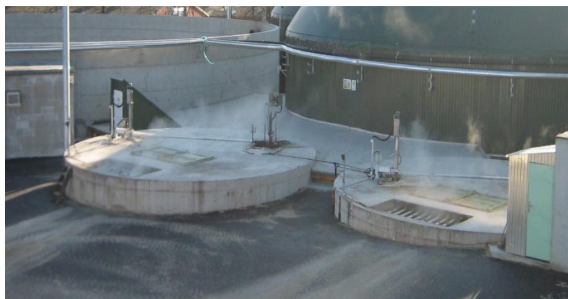
Obr. 5. Sestava nádrží vstupních jímek v Pěčíně [Zdroj: vlastní]
