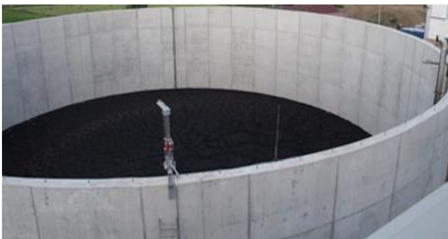
Obr. 7. Pohled do koncového skladu digestátu v Pěčíně [Zdroj: vlastní]
