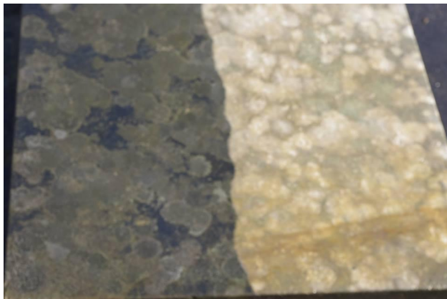
Obr. 1: Ukázka prachového znečištění na mramorové dlažbě
