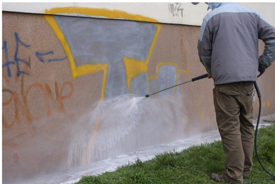
Obr. 4: Ukázka vysokotlakého čištění graffiti pomocí detergentů
