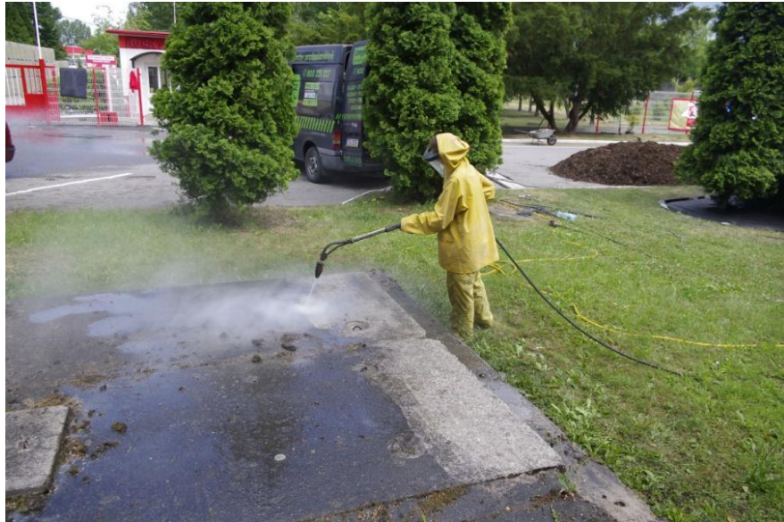
Obr. 13: Kombinace chemického a tlakového čištění
