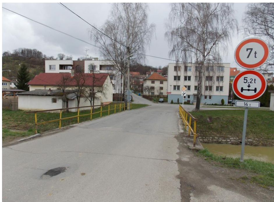
Obrázek 7 – Most v ulici Stráň – současný stav (vlastní zpracování)
