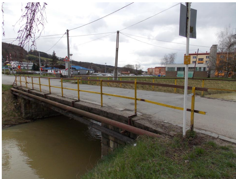
Obrázek 6 – Současný stav mostu v ulici Stráň (vlastní zpracování)
