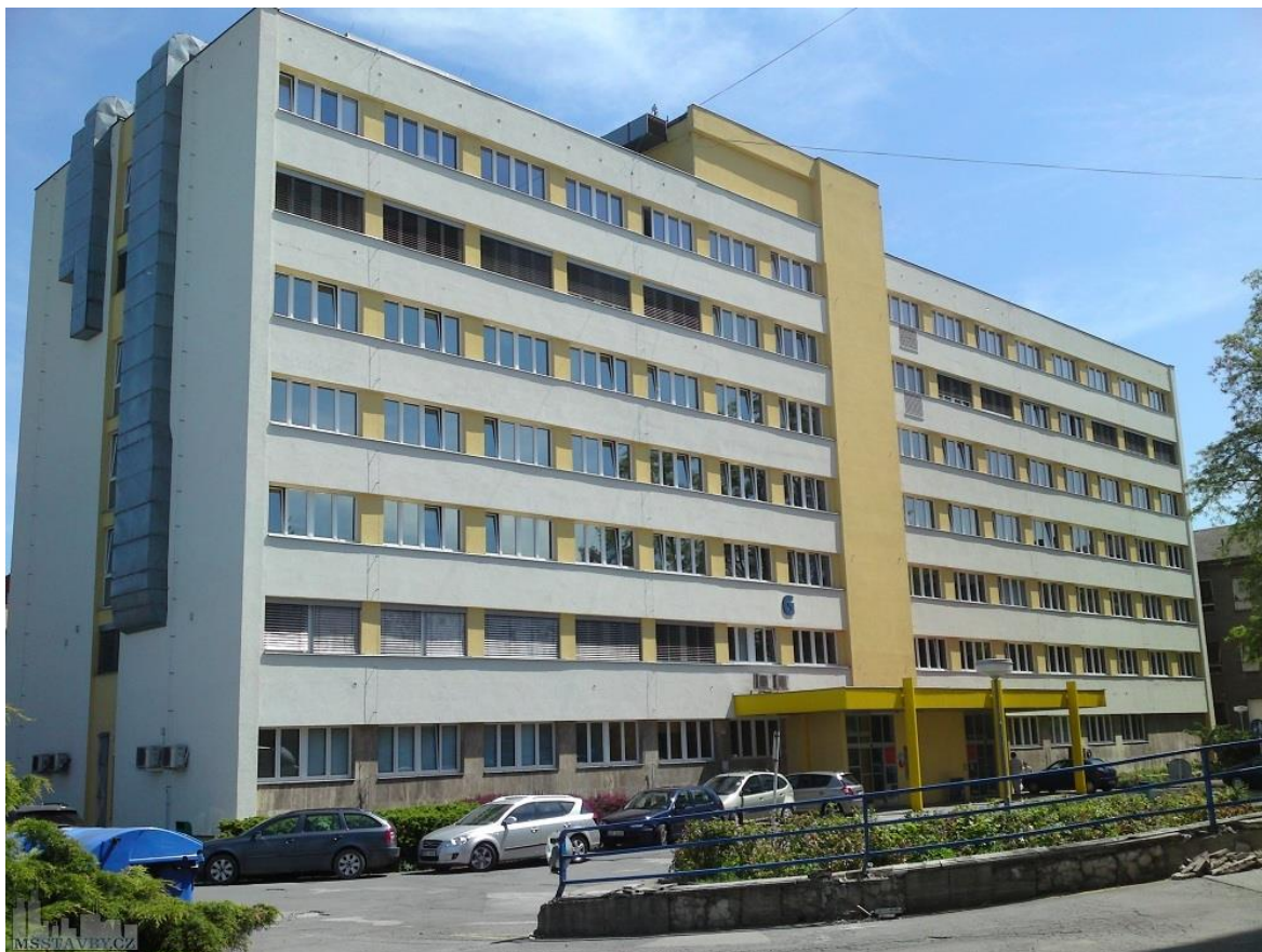
Obr. 2 Pavilon Gastroenterologie a Vaskulární centrum (msstavby, ©2012)
