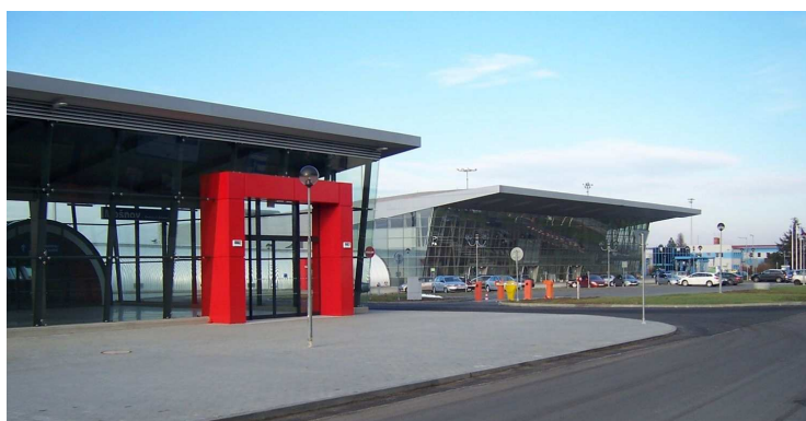
Obrázek 17: Pohled na železniční a odbavovací terminál LLJO (Zdroj: Letiště Ostrava, a. s., 2015)
