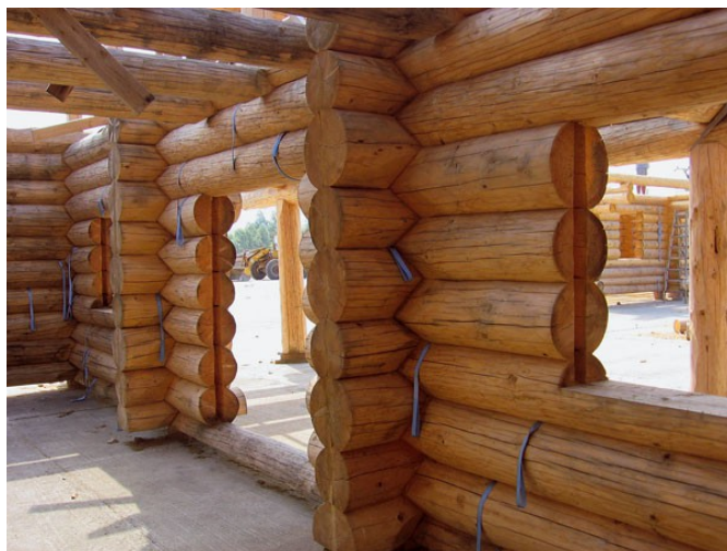
Obr. 12. Ukázka srubové konstrukce
