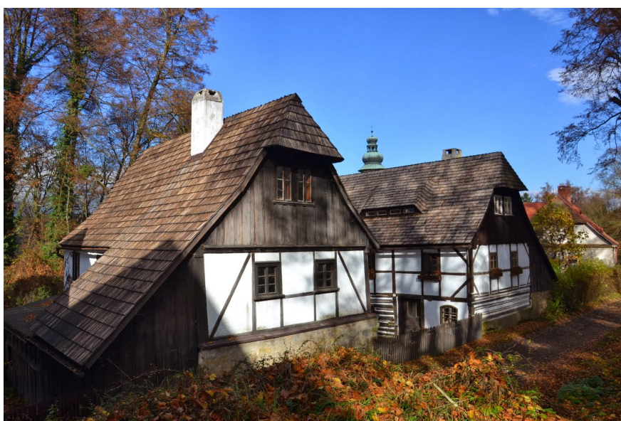
Obr. 15. Ukázka hrázděné architektury
