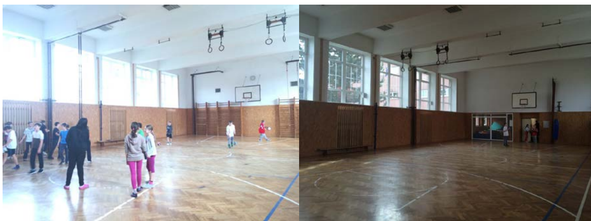
Obr. 4: Fotografie stávajícího stavu tělocvičny severozápadní a jihovýchodní stěna
