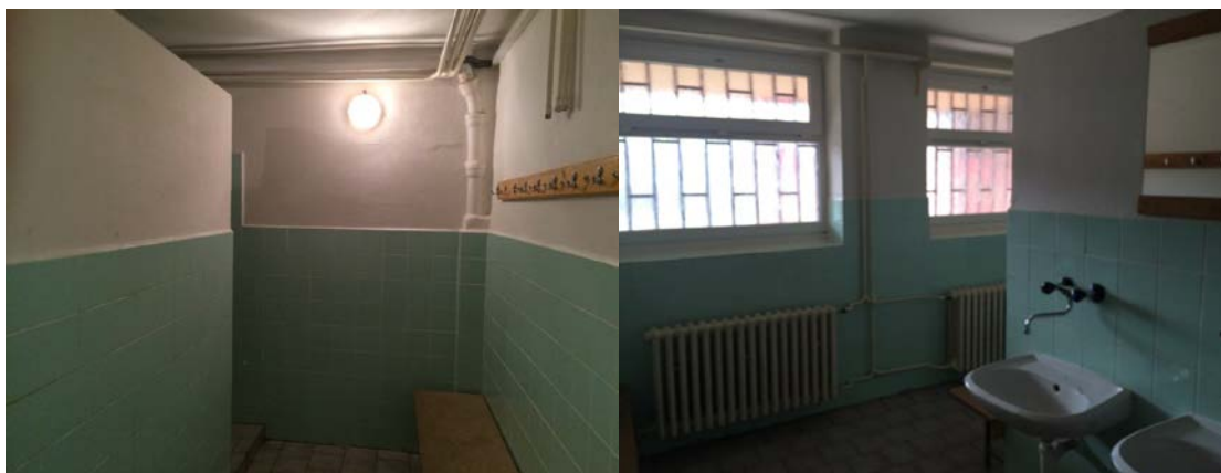
Obr. 3: Fotografie stávajícího stavu koupelny
