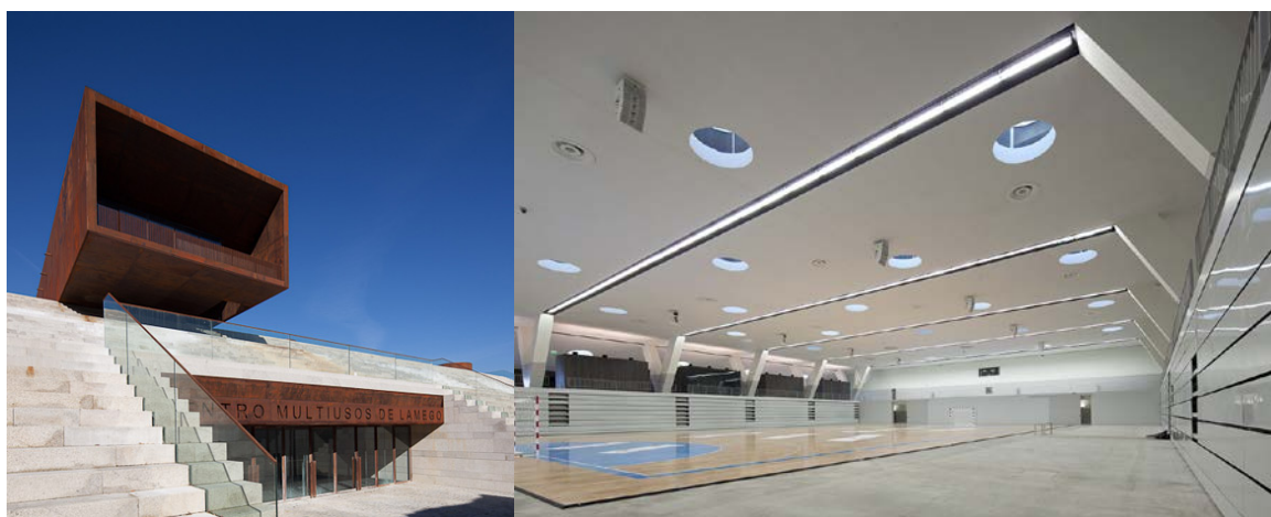
Obr. 9: Centro Multiusos de Lamego
