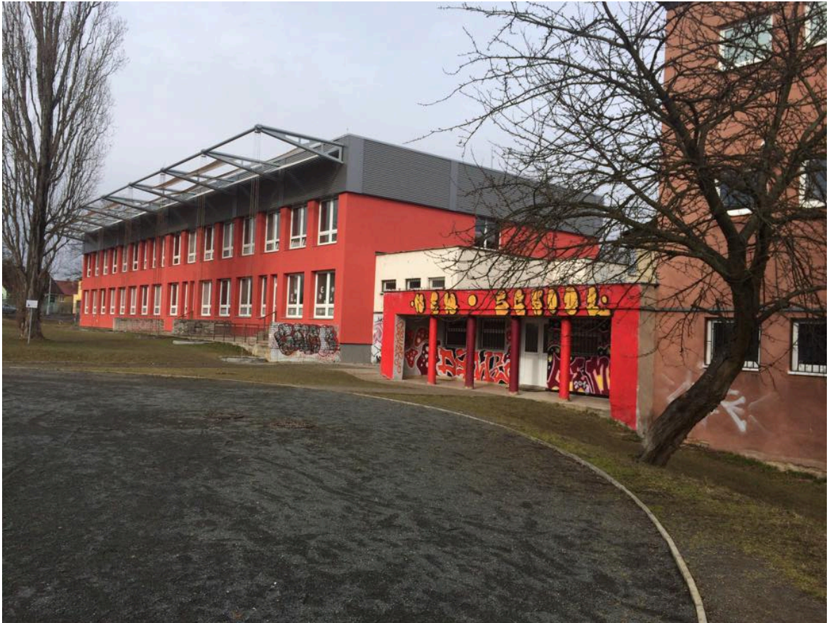
Obr. 33: Původní stav budovy
