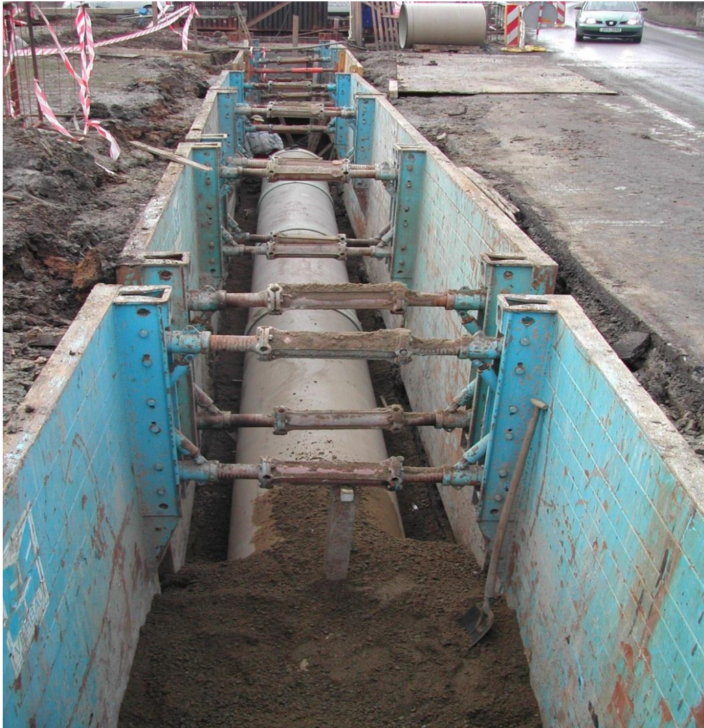
Obr. 10 Výstavba kanalizačního sběrače (interní materiály společnosti XYZ, a.s.)
