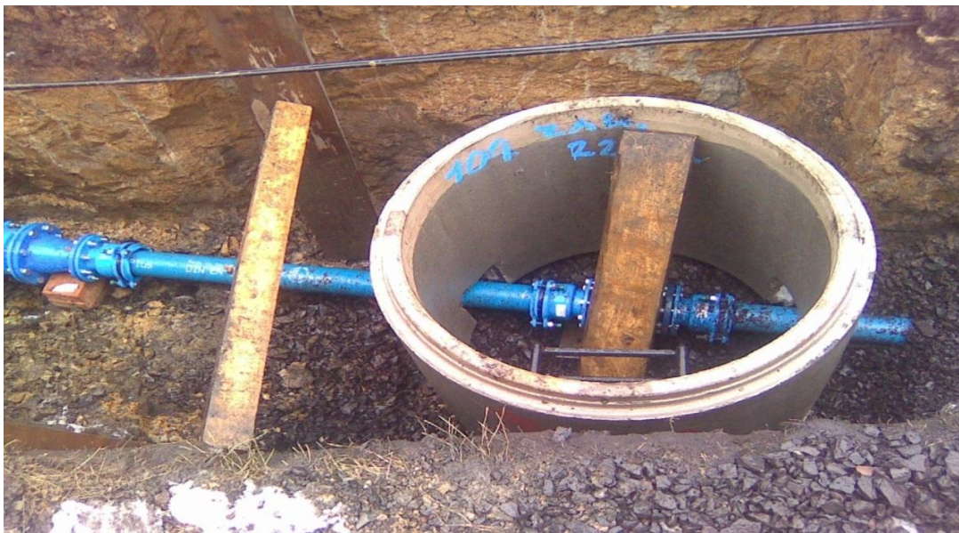
Obr. 9 Výstavba monitorovací šachty na vodovodním řadu (interní materiály společnosti XYZ, a.s.)
