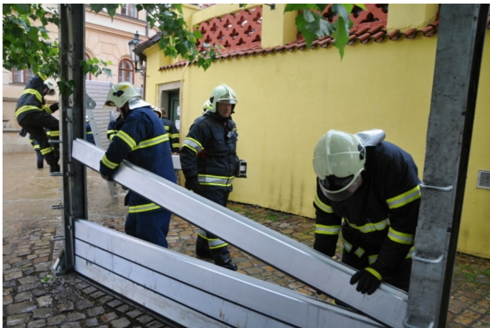
Obr. 14. Jednotka HZS při stavění protipovodňových hrází,
