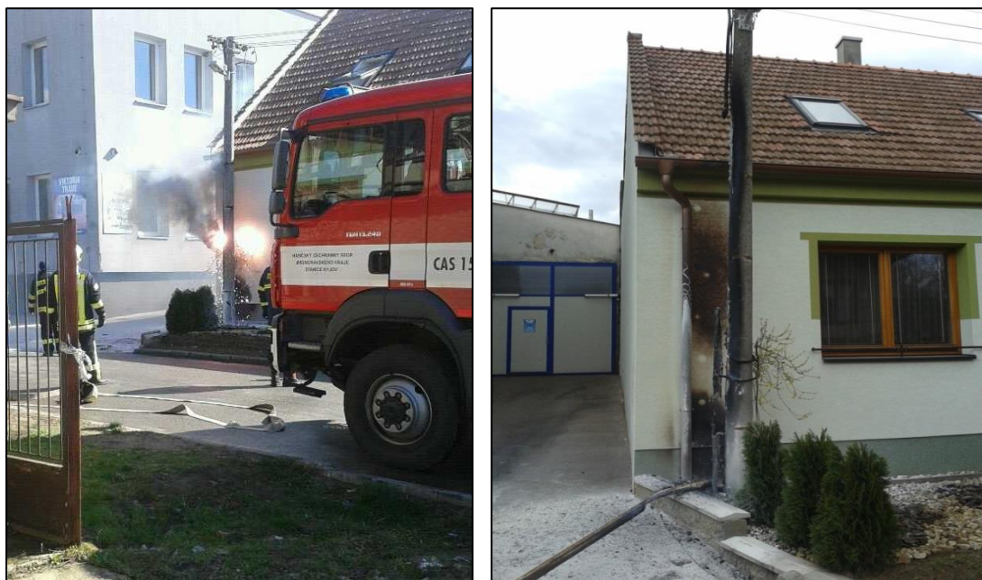
Obrázek 5. Požár sloupu NN u RD, následky požáru [vlastní]
