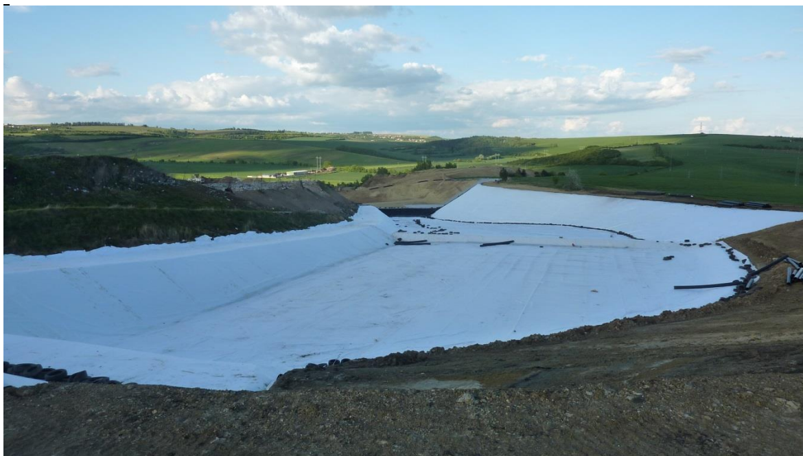
Obrázek 4. Výstavba V. etapy skládky [vlastní]
