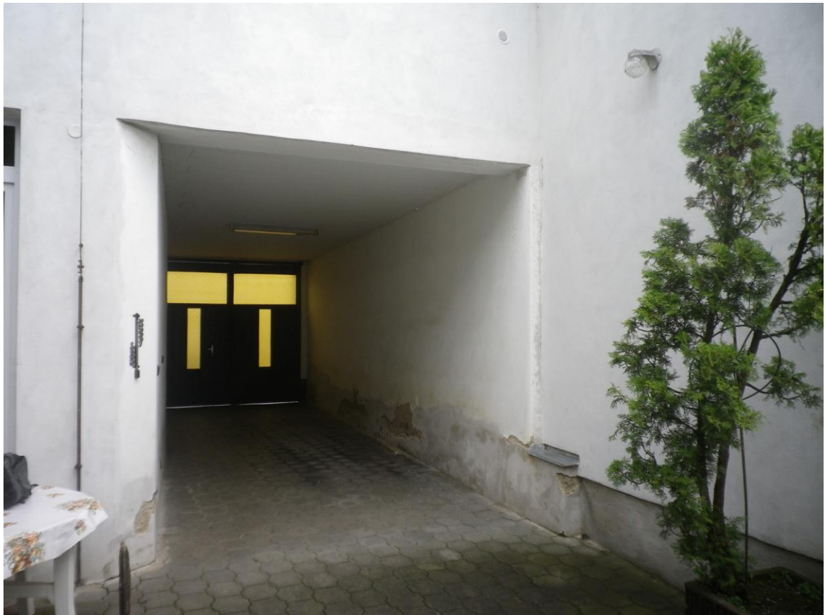
Obr. 21 – Pohled na průchod
