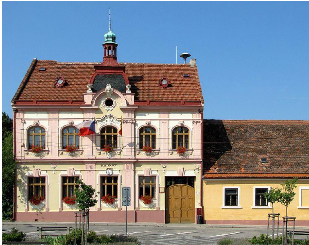
Radnice (hlavní budova městského úřadu) na náměstí Svobody
