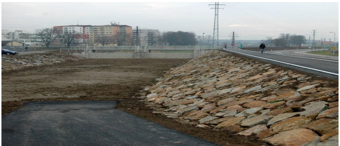
Obr. 11 Protipovodňové hráže v Uherském Hradišti
