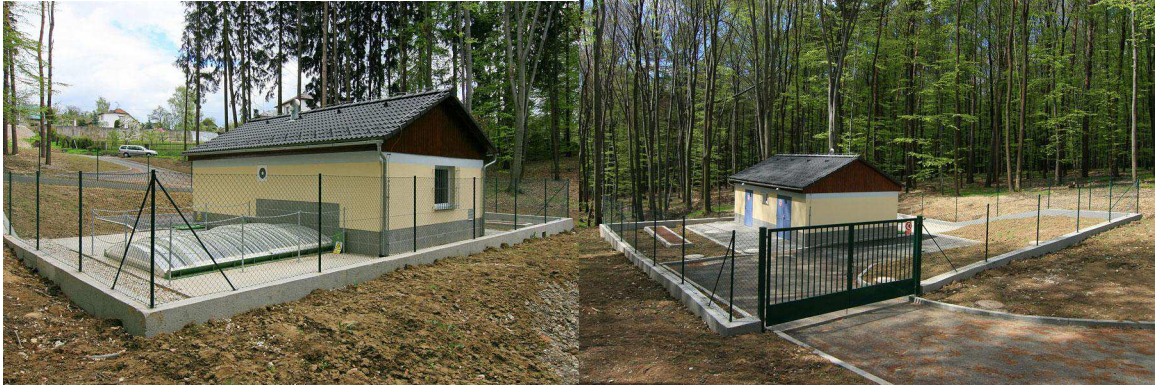
Obr. 13 Výstavba nové čerpací stanice, provozní domek
