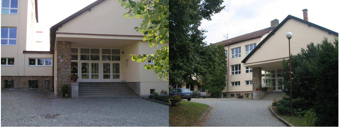
Obr. 15 Budova ZŠ a MŠ Osvětimany po rekonstrukci
