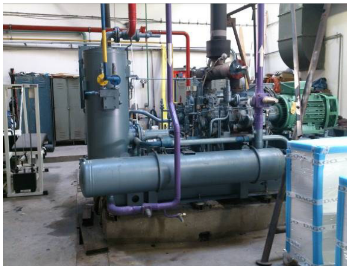
Obrázek 2 – Dvojkompresor typu LD-5B GEA Grasso
