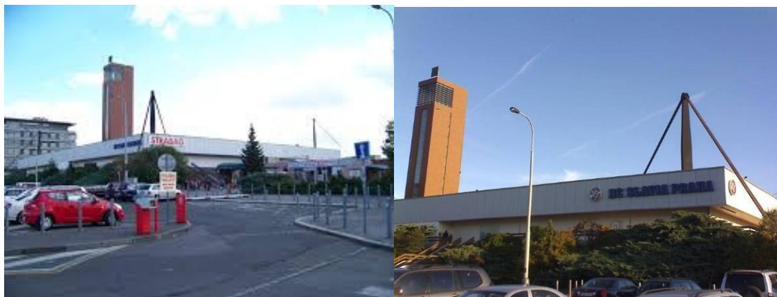
Obrázek 1 – Pohled na čelní stranu zimního stadionu (foto autor)
