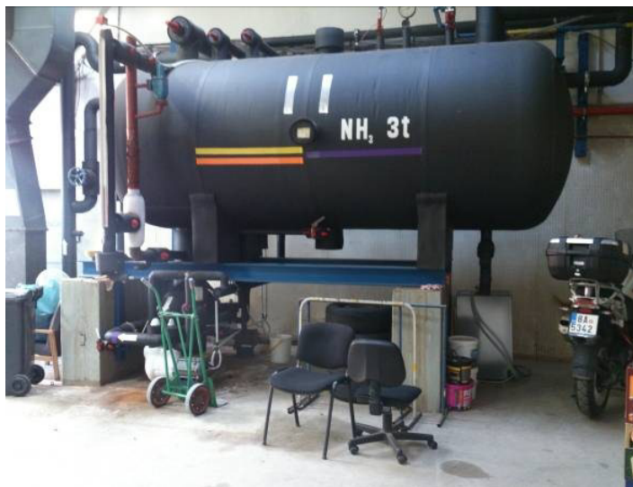
Obrázek 3 – Zásobní nádrž NH_3 o objemu 10\text{ m}^3
